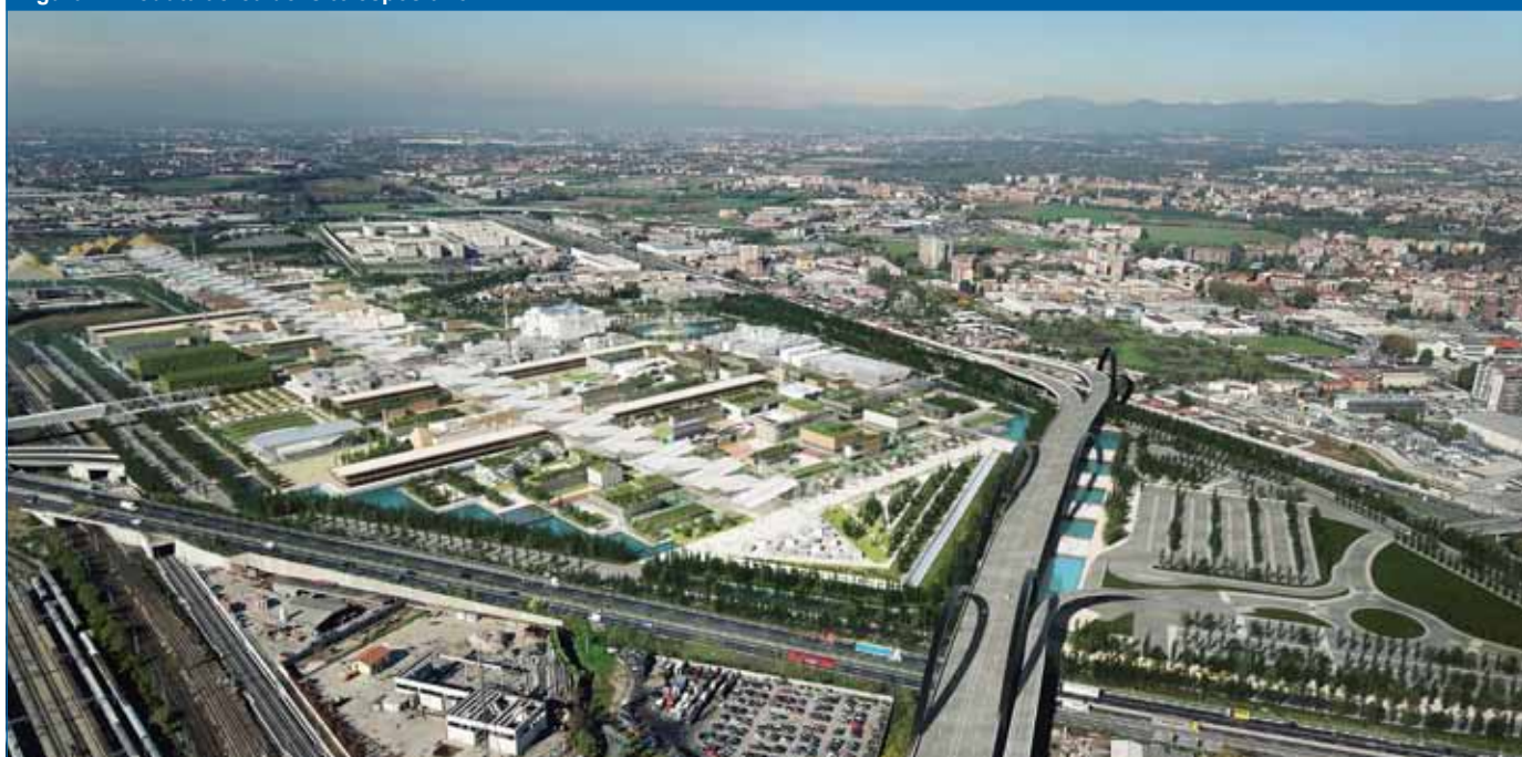
Figura 1 - Veduta aerea del sito espositivo
