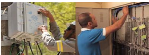
Posa MSAN su palo e Rete secondaria corta
